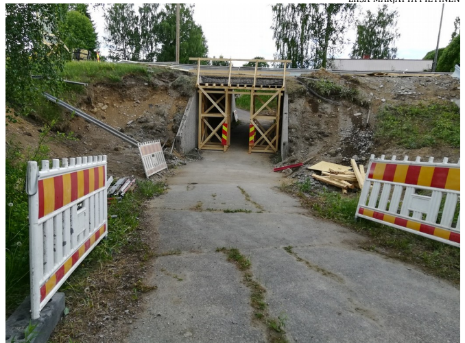
Alikulikutunnelit on tehty vuonna 1983 kuten kevyenliikenteenväyläkin. Tunnelien kohdalta ajotien pinta uusitaan, tunnelit vahvistetaan ja maavallit tuetaan veden valumisen estämiseksi.
