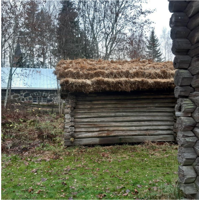
Uudet katot ovat olkea ja peltiä.
