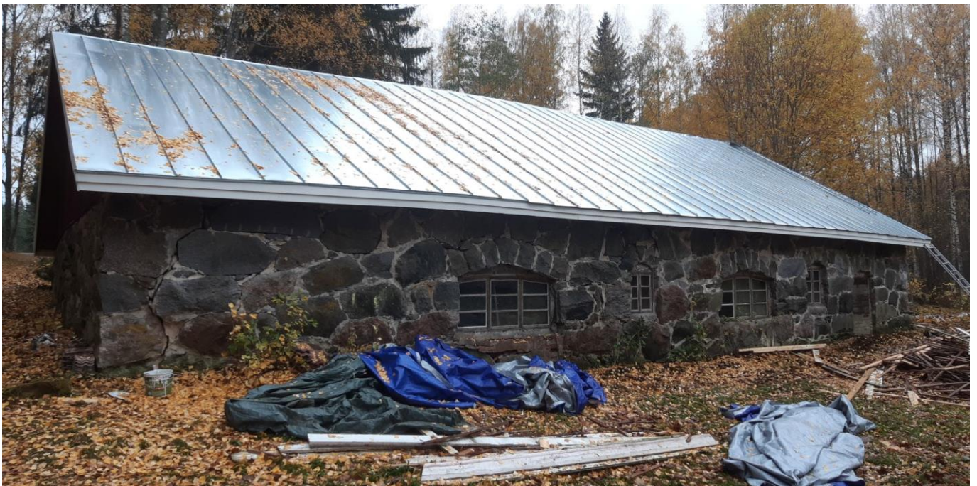
Melkein valmis navetan peltikatto.
