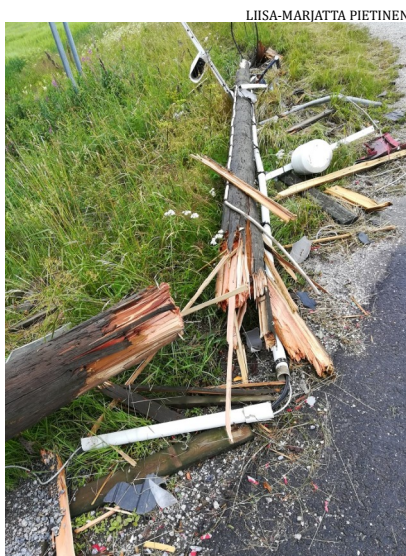
Aamuyöllä 7.7.2019 säätolppaan ja Karsillantien toisella puolella olevaan tolppaa törmäsi henkilöauto. Auto päätyi vaurioista päättellen katon kautta ympäri bussikatoksen viereiseen ojaan.
