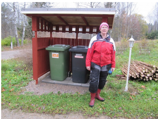
Eija Niinimäki on saanut uuden jätekatoksen valmiiksi, johon mahtuu vaadittavat säiliöt energia- ja sekajätteille.
