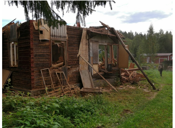
Vahvempia hirrenpätkiä ja pärekaton suikaleita jäi odottamaan pariskunnan uusia rakennushankkeita.
