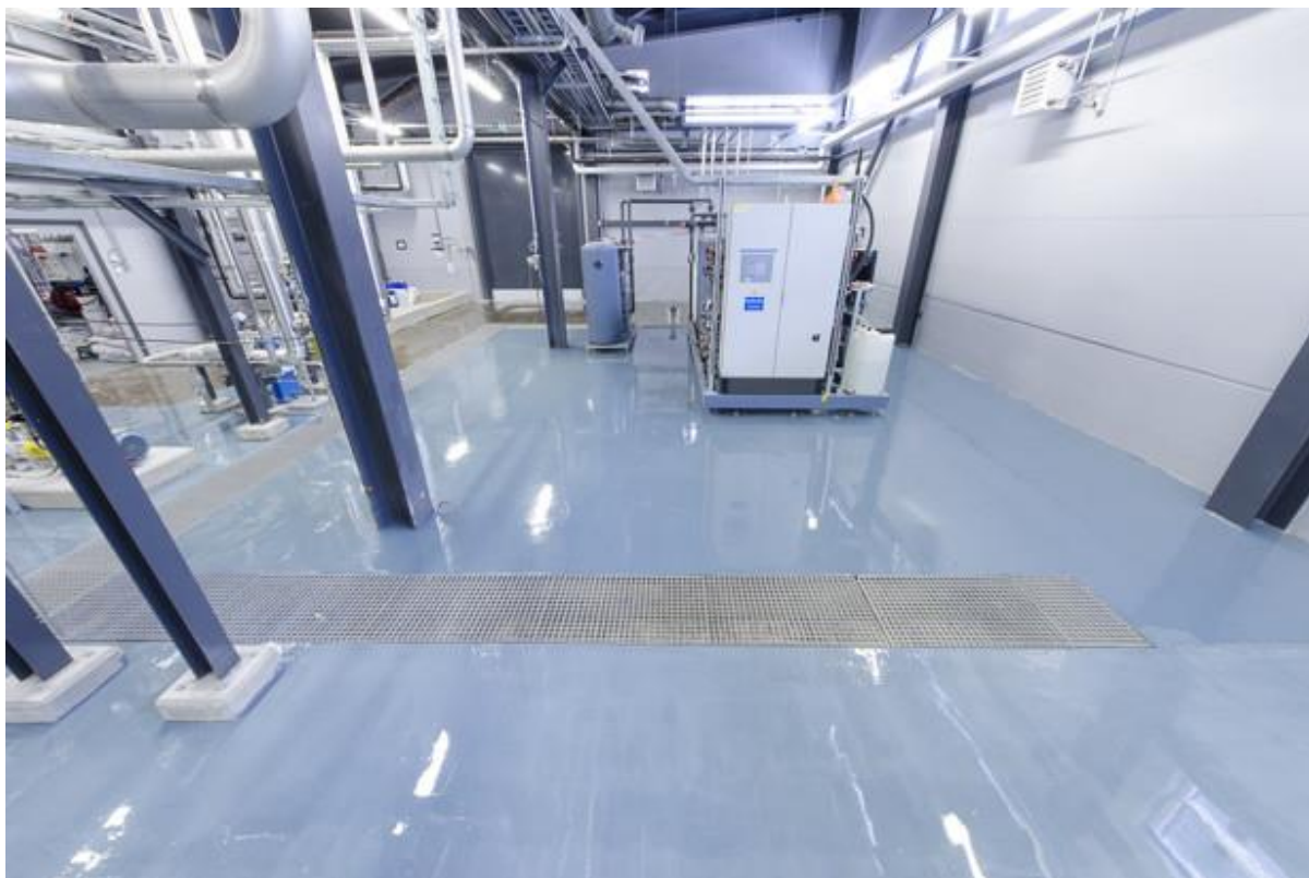
Kuva 72. IV- konehuone lattiapinnoite ARMEKA-Finneste Polyureapinnoitteella.
