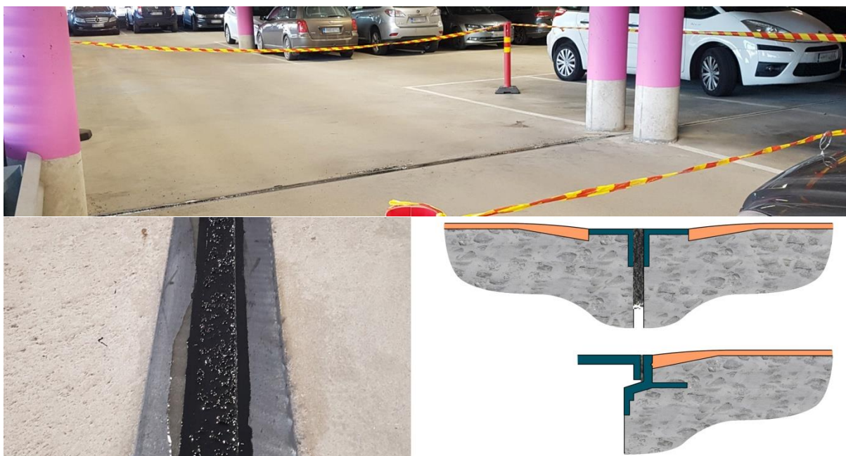
Kuva 73. Liikuntasauman korjaus kumirouheella.
