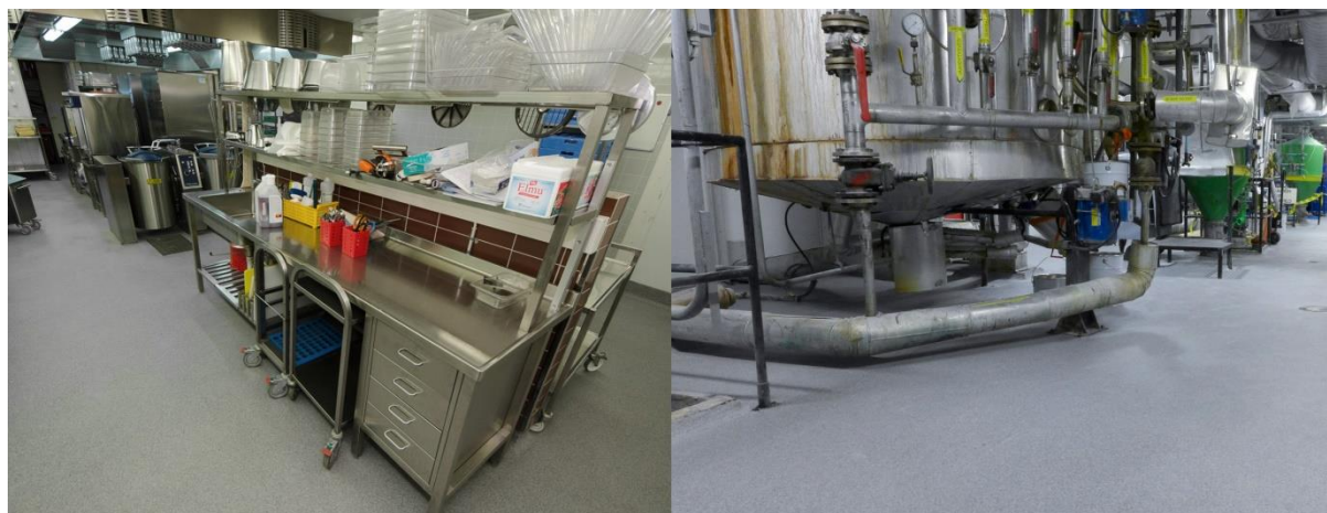
Kuva 66. Kosteuden rasittamia tiloja, jotka on pinnoitettu ARMEKA STB -hiertomassalla.
