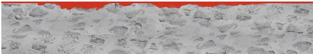
Kuva 6. Lattian tasoitus. Betonilattian pinta tasoitetaan epoksikitillä (kuvassa punaisella) ennen muita pinnoituksen vaiheita.
