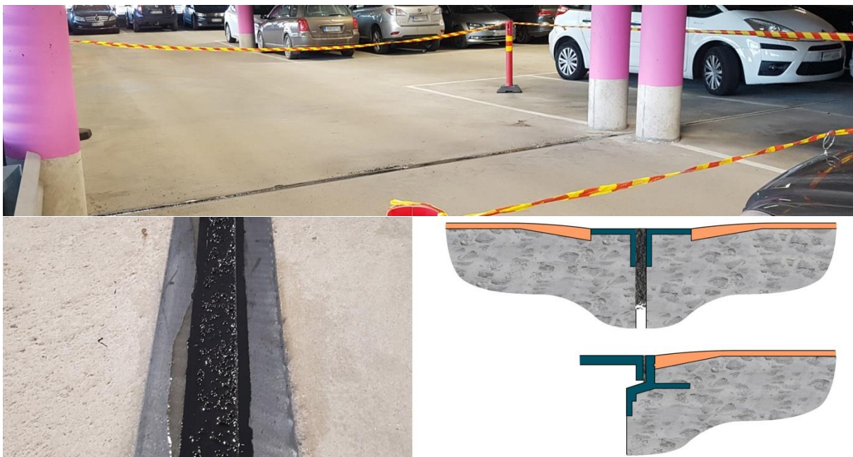
Kuva 73. Liikuntasauvan korjaus kumirouheella.
