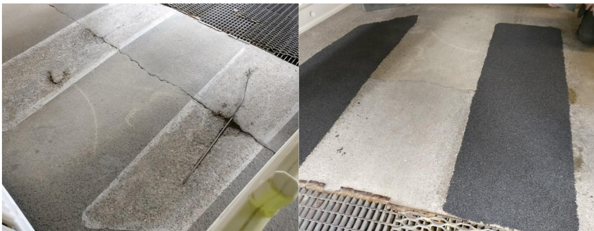
Kuva 63. ARMEKA Korundikivikorjaus ajoramppiin, ennen (vasen) ja jälkeen (oikea) -kuvat.
