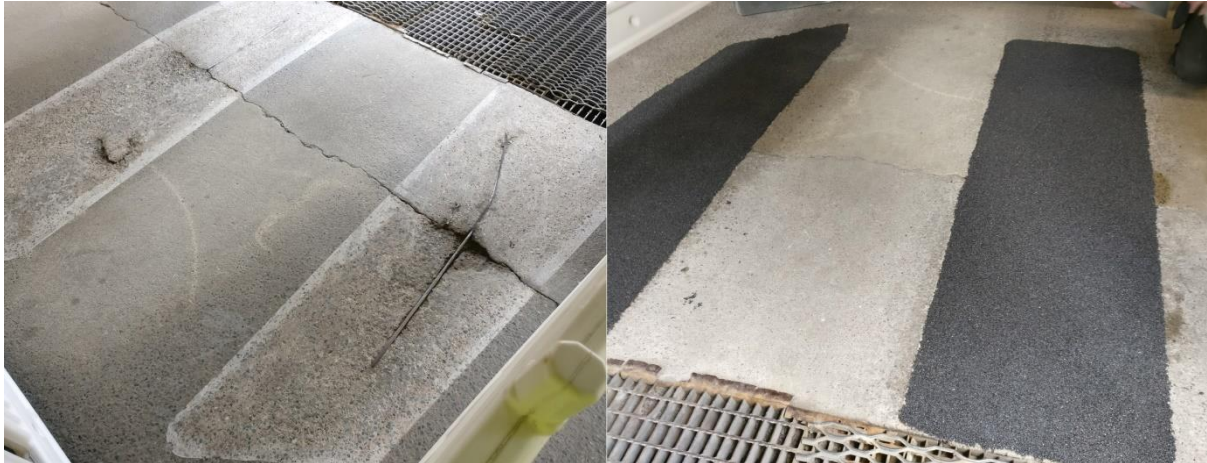
Kuva 71. ARMEKA Korundikivikorjaus ajoramppiin, ennen (vasen) ja jälkeen (oikea) -kuvat.
