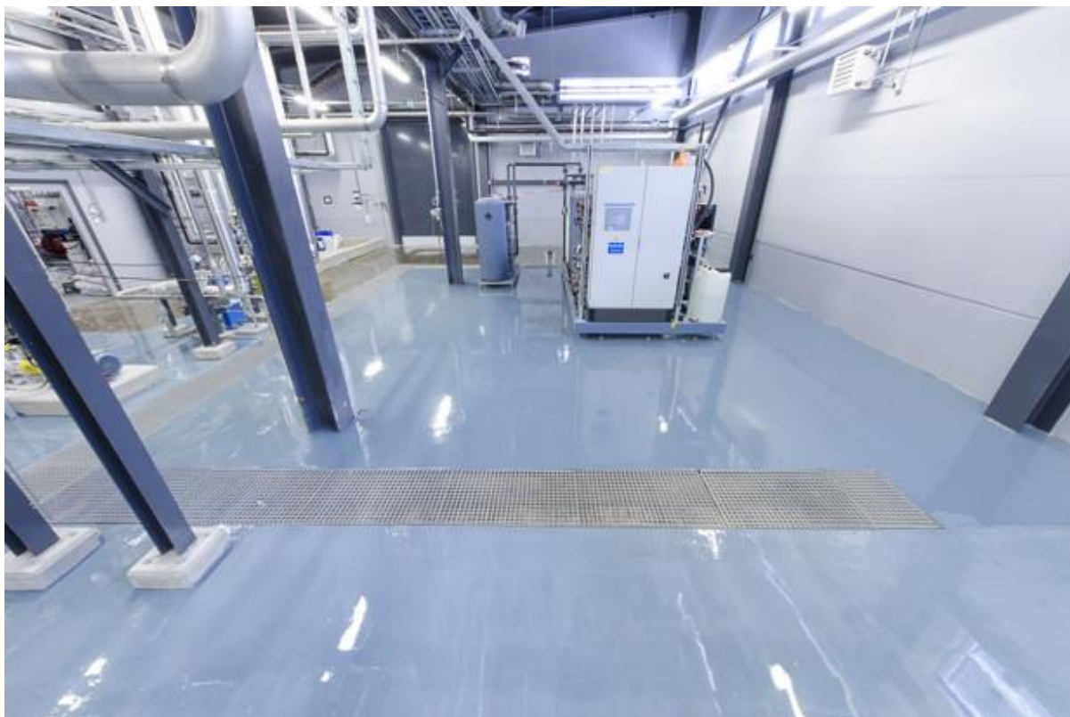
Kuva 72. IV- konehuone lattiapinnoite ARMEKA-Finneste Polyureapinnoitteella.
