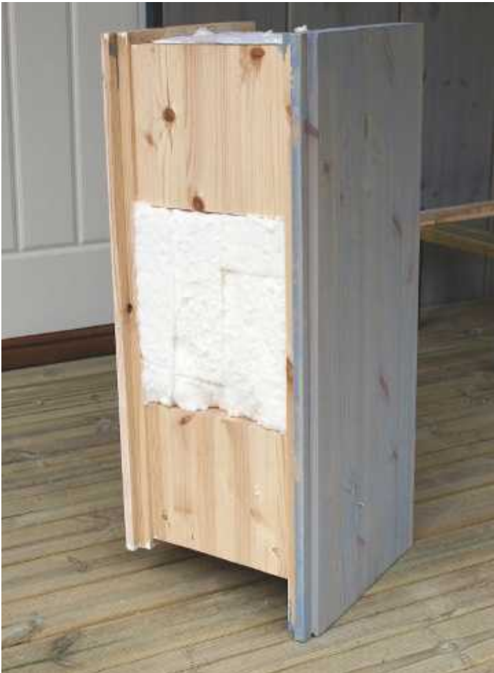
Ikkuna- ja oviaukkoja sisältävissä seinäosissa käytetään myös lyhyitä elementtejä. Kuva paljastaa elementin rakenteen: ulko- ja sisäseinän, välikappaleet sekä eristeen. Elementin pituudesta johtuen välikappaleiden määrä vaihtelee kahdesta neljään.
