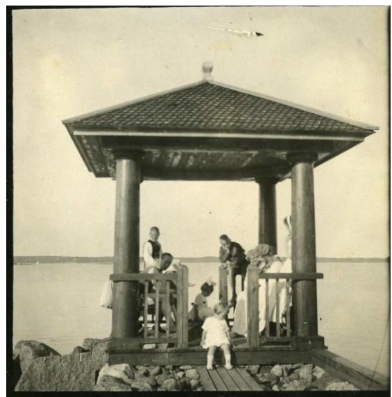
Aurinkokatos ja laituri keskeneräisenä 1920
