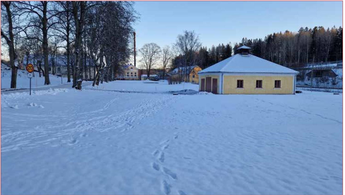
Spruthuset från 1926 är Botkyrka-Grödinges första brandstation
