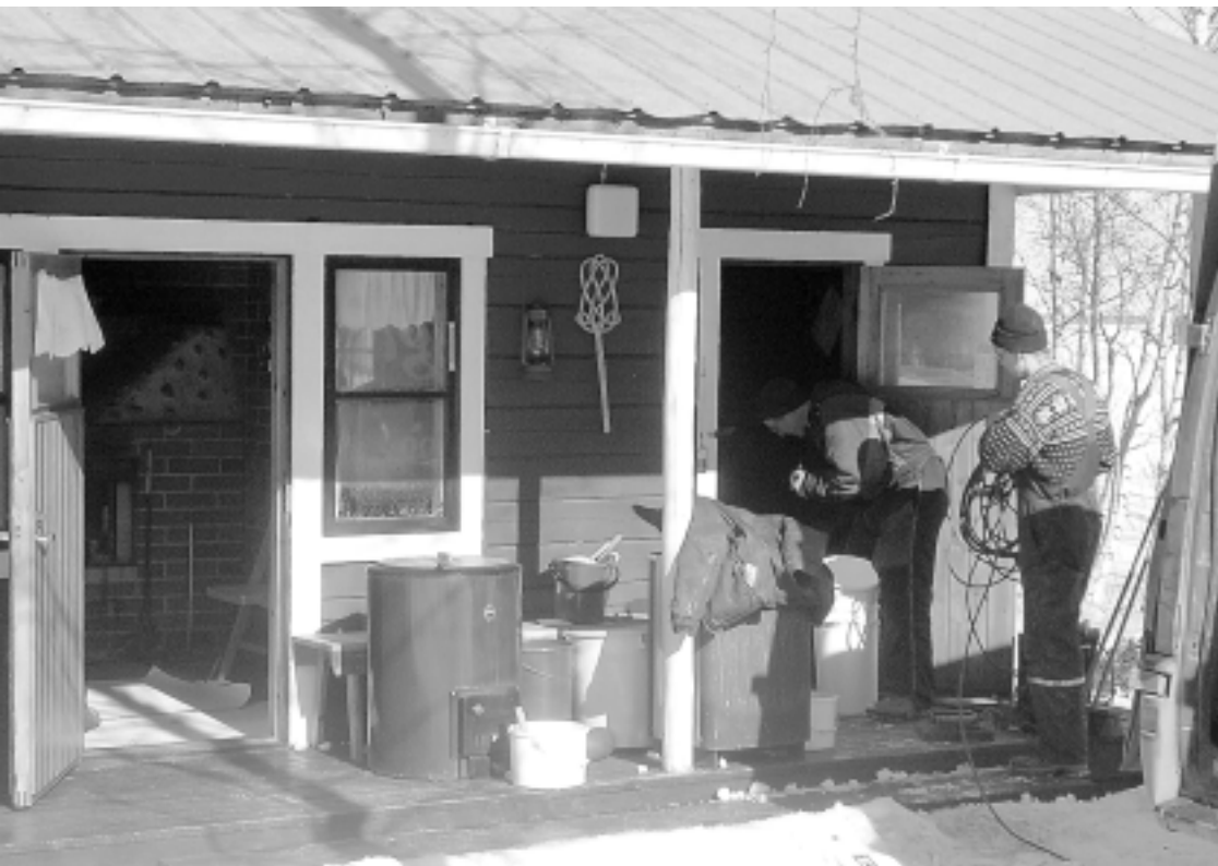
Röytän sauna on remontin jälkeen entistä ehommassa kunnossa.
