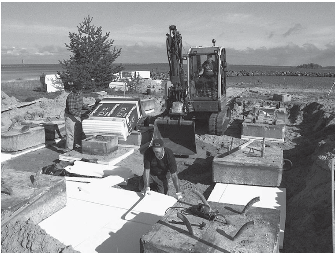
Kesäkeittiön perustukset ovat jämerää tekoa.
