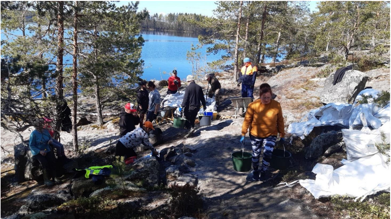
Kivituhka levittyy Linnansaaren kansallispuiston luontopolulle sankoilla kantaen ja kottikärryillä hiissaten.
