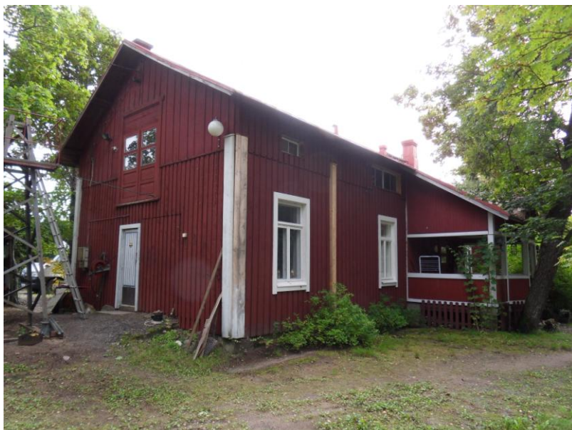
Suoja / Perniön raittiusyhdistys Sulku I
