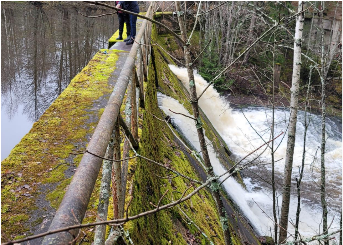
Kuva 5. Padon harja, korkotaso noin N2000+49,20-49,28 m
