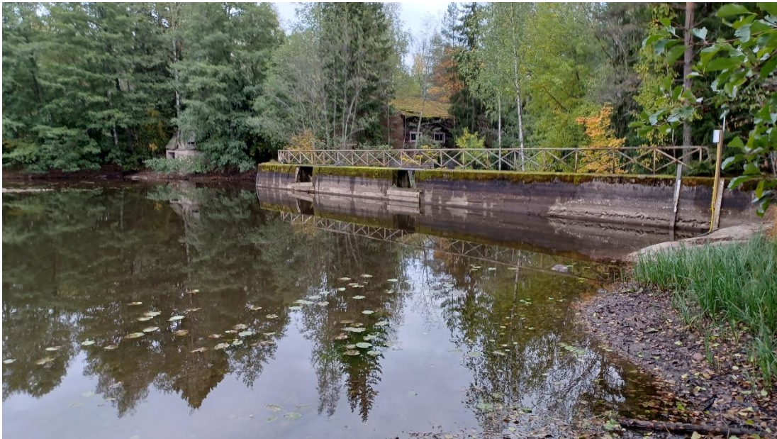
Kuva 4. Säännöstelypato kuvattu alhaisella vedenkorkeudella ylävirran puolelta
