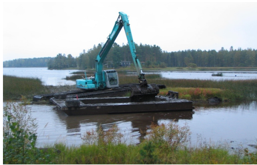
Kaivinkone proomun täytössä
