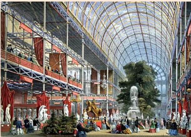
Kuva 25 SUURI KASVIHUONE. Lontoon Crystal Palacen poikkilaiva Maailmannäyttelyn aikana. Pinta-alataan 92 000 neliömetrin palatsissa oli avajaisnäyttelyn aikaan tilaa 15 000 vierailijalle
