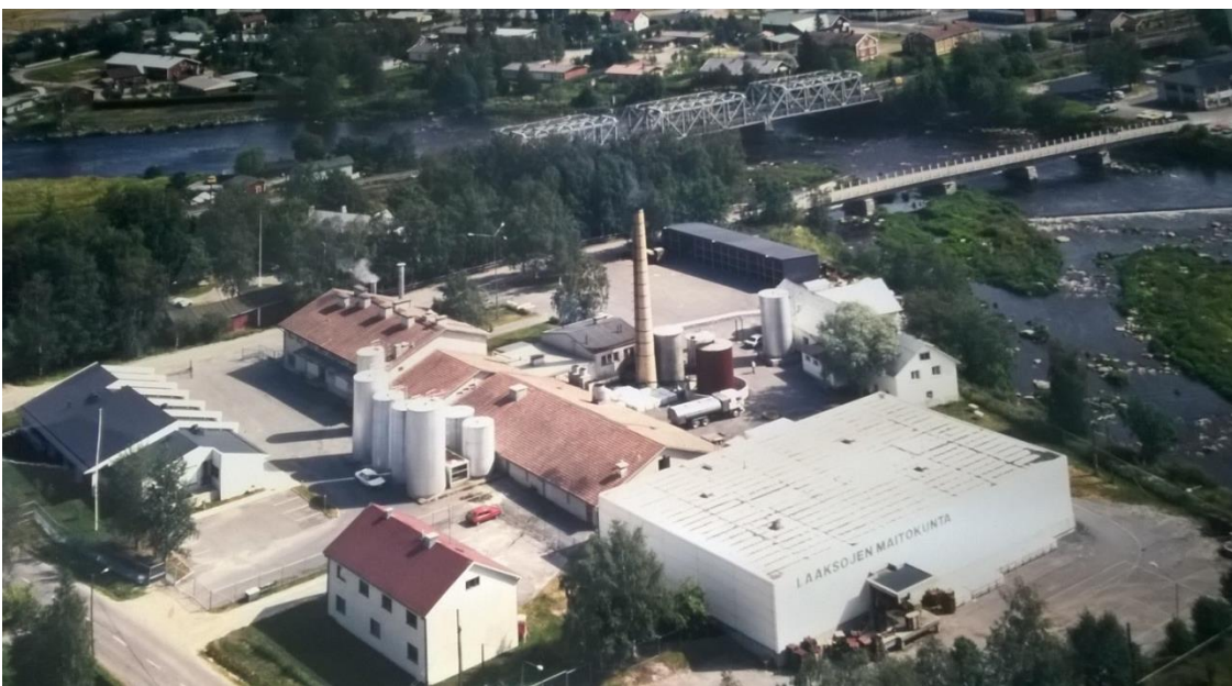
Laaksojen Maitokunnan rakennukset 1980-luvulla. Takana näkyy Savisilta ja vanha rautatiesilta.
