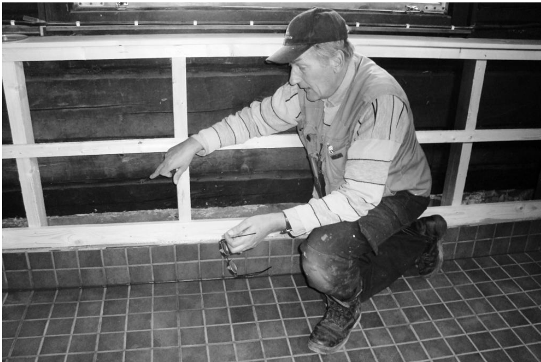
”Hasse” Killan saunan pesuhuoneremontin aikaan
