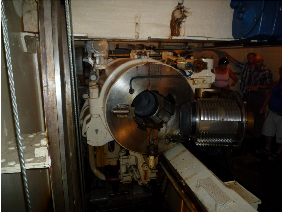
12” kanuunan torni sisältä.
