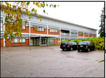
Lieksassa on on pitkät perinteet sairaalarakennusten tuhoamisesta. Oikealla Yrjö Lindgrenin (mm. Stadikan piirtäjä) arkkitehtitoima Pielisjärven sairaala, joka on korjaamattomassa tilassa ja yllä nykyinen terveyskeskus, joka on yksityisen ”investorin” tieltä hävitettävä.
