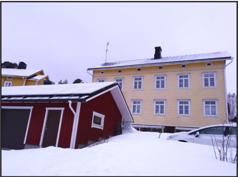
Sahan työläisten kaavalla suojeltu asuintalo Porvoossa 1800-luvulta. Talotekniikka uusittu: vesi, viemerointi, sähköt. Lämmitys perustuu seitsämään korjattuun tai uusittuun tulisijaan. Rakennettu lämmön talteenotolla toimiva koneellinen ilmastointi jne.
