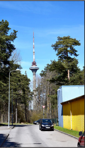
Olympialaisten alla myös Piritan kau-punginosaan - 3 km olympiakeskuk-sesta - rakennettiin televisiokeskus ja tv-masto. Rakennustyöt aloitettiin 30.9.1975 ja virallisesti työ valmistui kisojen alla 11.7.1980. Torni (314 m) on Viron korkein rakennus.
