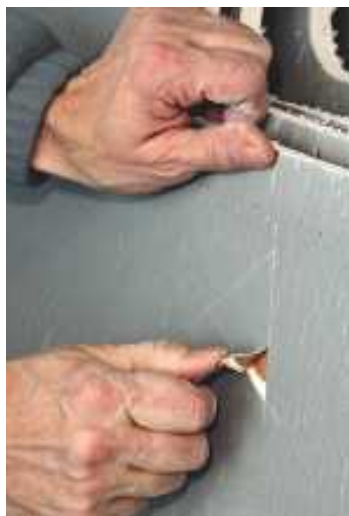
Kuivakalvon paksuudesta saa ottaa itsekin näytteen. Mattopuukolla leikattavasta kolmiomaisesta koekappaleesta voi mitata helposti toteutuneen kalvopaksuuden. Reikä on vain muistettava sulkea huolellisesti samalla eristeellä.
