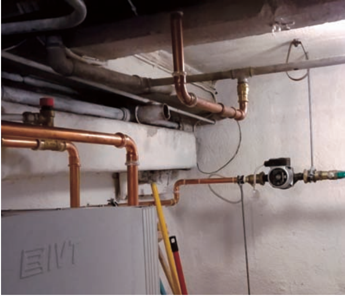
Uudet putket kulkevat joko katossa tai aivan lattian yläpuolella
