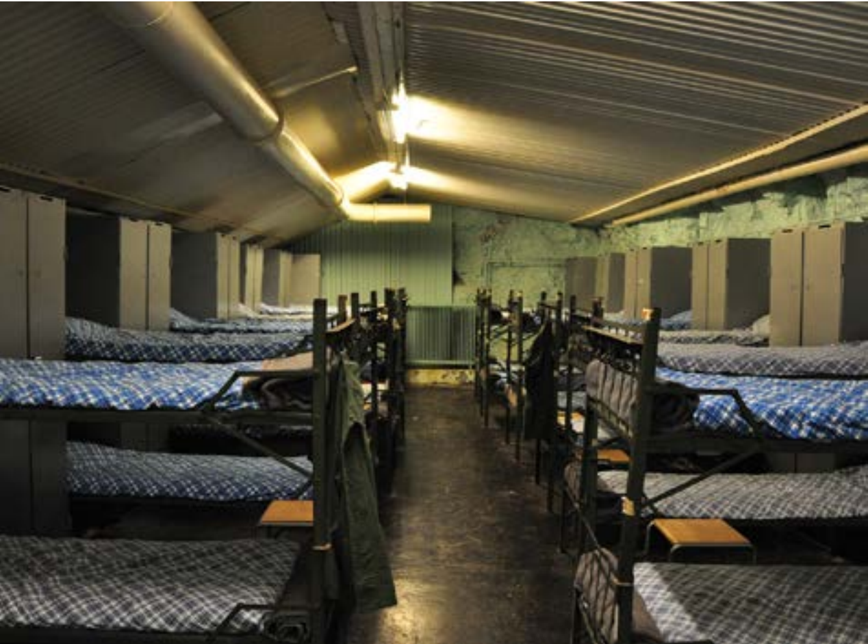
Pietarsaarensuudon Reserviläiset vierailivat kesällä Norbottenissa, Bodenissa ja Siknäsins linnakkeella Tören kylässä Kalixin kunnassa. Kuvassa näkyy peltikatto ja räystäs, joka asennettiin mm. Rödbergetin linnakkeen majoitustilaan, jottei kondenssivettä tippuisi nukkuvien päälle. Jakobstadsnejdens Reservister gjorde i somras ett besök till Norrbotten. På bild syns förlägningsrum i Rödbergsfortet med inre plättak för att förhindra att kondensvatten droppar ner på de sovande.
