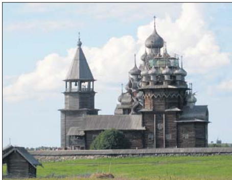
Kizin kesä- ja talvikirkko muodostavat laivan. Talvikirkon kattopaneuja korjataan.
