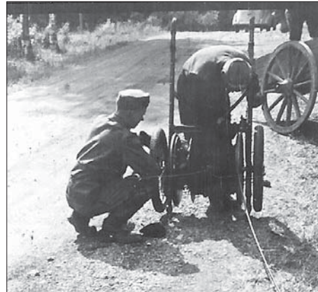
Kenttäkaukokaapelilinjan rakentaminen Leppäsjärvellä kesällä 1944 (kuva: majuri Olli Vuorio).
