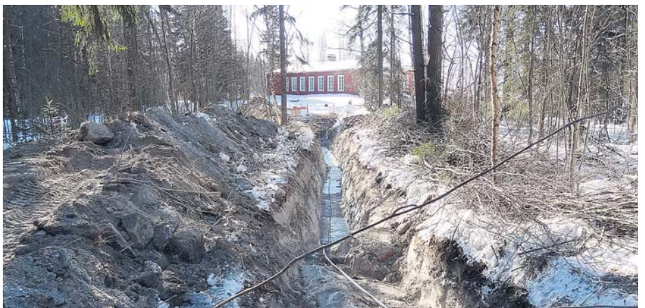
Vesijohtoverkosto lähestyy kohti taustalla näkyvää Kiltataloa. Peruskallio tuli vastaan paikoittain ja vaatii louhintaa. rl
