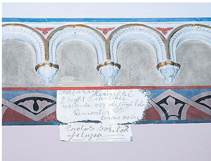
Hovioikeuden peruskorjauksen yhteydessä maalikerrostenalta paljastui maalari Henrik J Flykt'in tekemä merkintä vuoden 1939 syyskuulta. "Puolas sorittaa ja luuraa".
