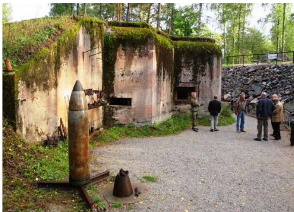
Massiivinen Irma-bunkkeri panssarintorjuntatykki- ja konekivääriaukkoineen. Edessä neuvostoarmeijan 300 mm rautatietykin ammus, jonka räjähdyskyn bunkkeri oli rakennettu kestäämään.
