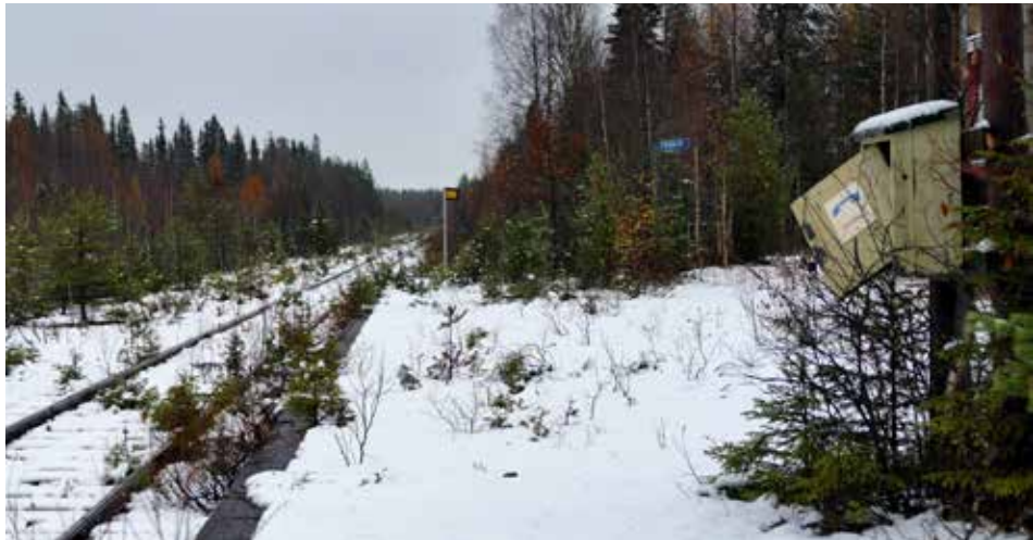
Sodan jälkeen saksalaisten kenttäradan pohjaa käytettiin monin paikoin maanteiden rakentamiseen, mutta kovemmillä maapohjilla sitä voitiin käyttää leveäraiteiseksi rakennettuna esim. puutavarakuljetuksiin, kuten täällä Vääkiön aseman alueella. Kuva: Jouko Liikanen
