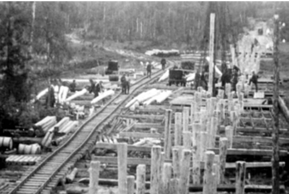
Junnosuon suosit. Pehmeään maastoon jouduttiin lyömään satamäärin paaluja, joita työn tehneet venäläiset sotavangit junttasivat 6 – 7 hengen porukoissa. Työ oli raskasta ja ravinto heikkoa, joten vankeja kuoli ratatyömaan aikana useita satoja. Vankien joukkohautapaikkoja on yhä vieläkin nähtävissä pitkin radan vartta. Tämän vuoksi kenttärata sai paikalliselta väestöltä nimityksen Kuolemanrata. Kuvakaappaus elokuvasta Rata – kuinka sota kohtasi korpikansan
