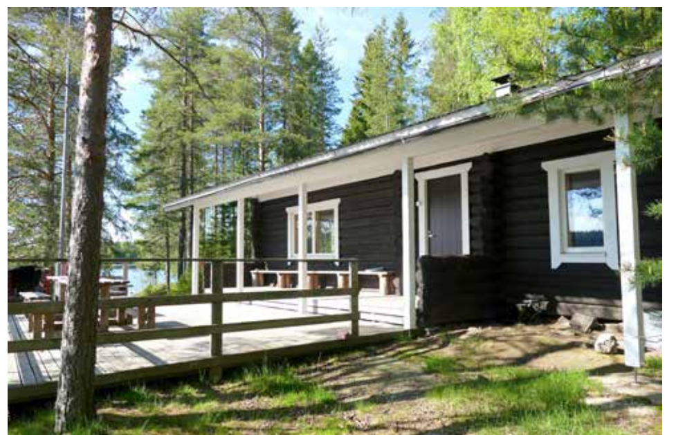
Vuonna 1964 rakennettu ja 2019 perusteellisesti remontoitu päärakennus Syvälahden rannalla.
