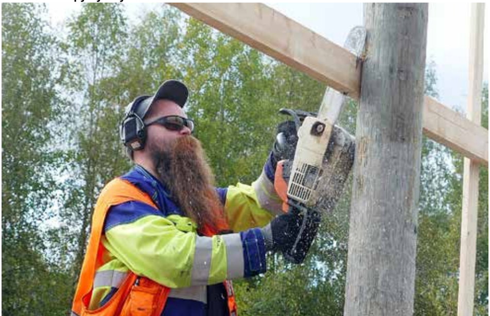
Työnjohtokin osallistui koko ajan varsinaiseen rakentamiseen. Veikko Suihkonen on kantanut vastuun käytännön töitten suunnittelusta ja rakennusteknisistä ratkaisuista. Kuva: Jouko Liikanen
