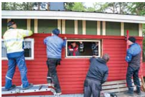
Ulkoseinien panelointi ja uusien ikkunoiden asennus.
