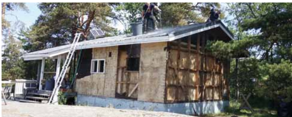
Remontin aloitus, pinnat poistettiin sisältä ja ulkoa, katto pestiin ja maalattiin.
