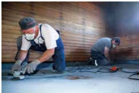
Lattiat hiottiin ja maalattiin.
