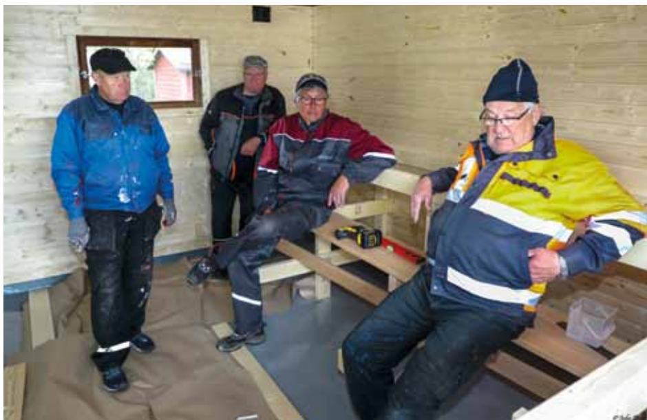
Lauteet uusittiin, seinät ja katot panelointiin.
