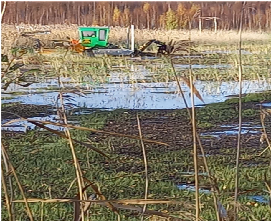
Kuva 4. Allikoiden avausta (Kaislapojat Oy)
