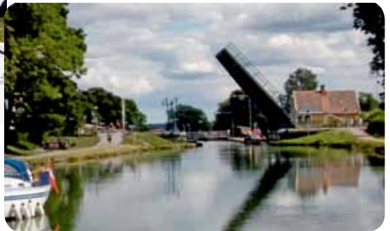
Sulku aukeaa, silta ylhäällä, saa mennä
