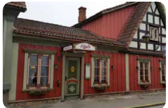
Näkymä kunnostetusta puutalosta Pärnun keskustassa
