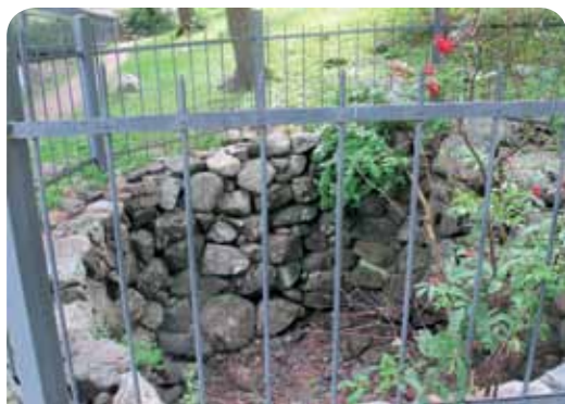
Armonlaakson kuivunut kaivo
