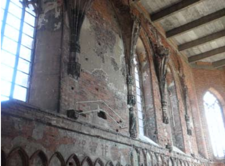
Kirkon alkuperäistä seinää näkyvissä
