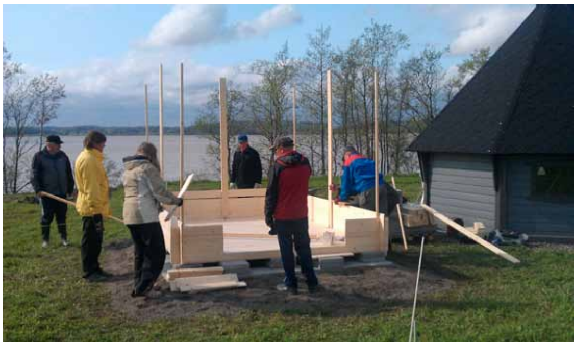
Varaston runko nousemassa.....
