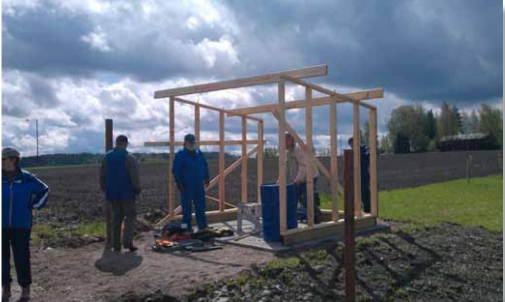
Roskakatoksen rungon pystytys menossa
