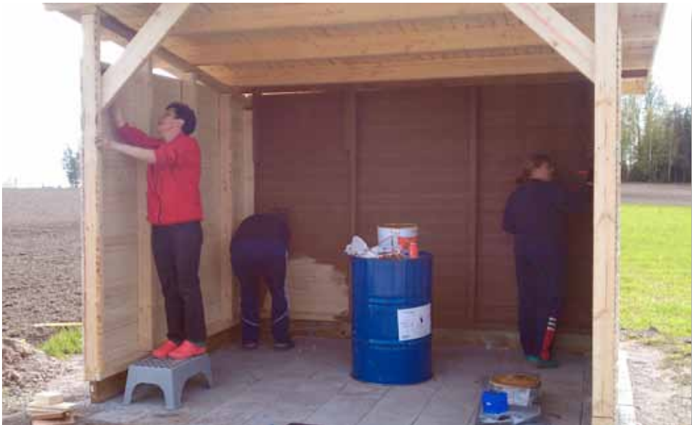
Lähes valmiin katoksen maalaustyöt käynnissä.
