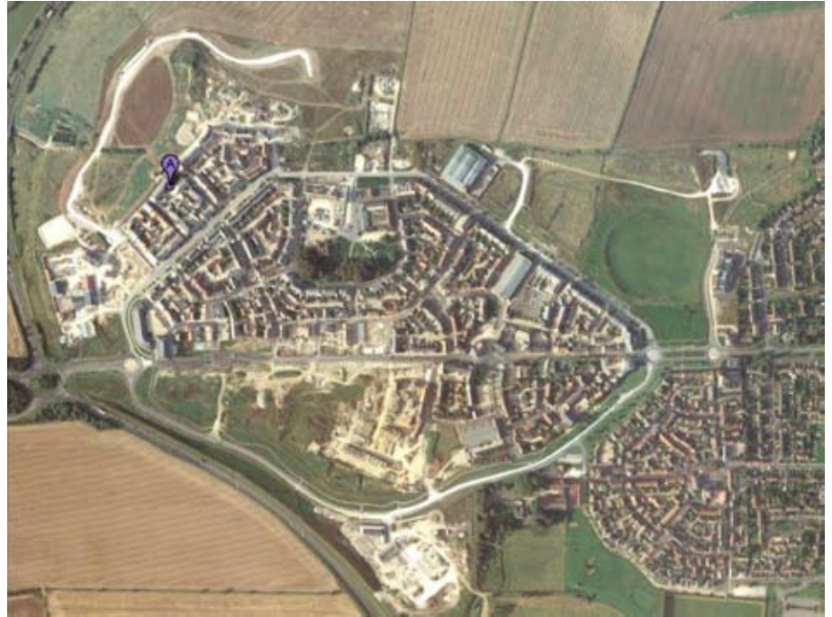
Kuva 5. Googlen ottama ilmakuva Poundburystä (1.9.2010).
