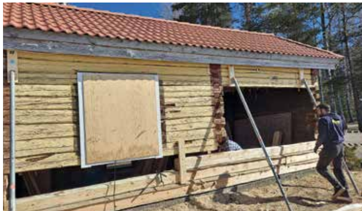
Takaseinän hirsityöt käynnissä.
