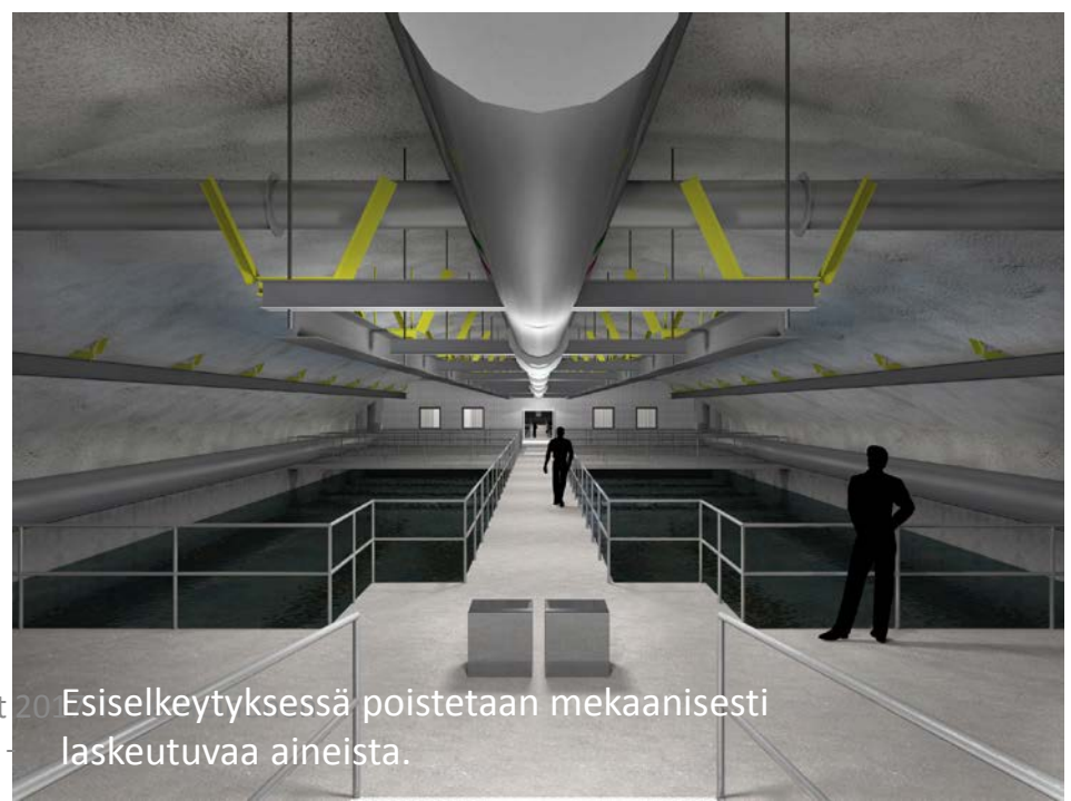
Käytävässä 1 täytetään ferrosulfaatin (fosforinpoisto kemikaali) altaita ja ajetaan pois hiekkaa ja välpettä
