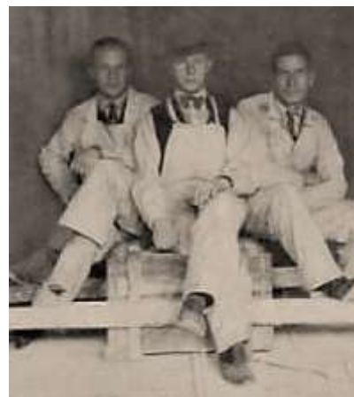
Savoy'n työmaa Helsingissä v. 1936/1937.
