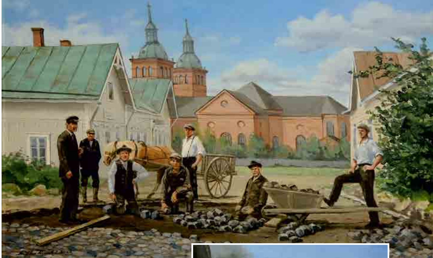
Vammalan Kirkkokadun kiveystyöt 1920-luvulla / n.60 x 90 cm / öljyväriyö vanhan valokuvan pohjalta 2025.
