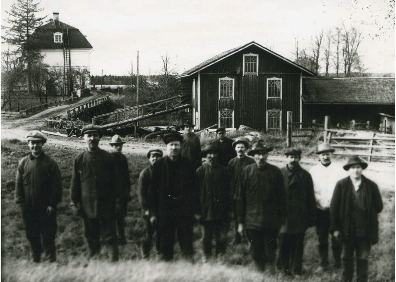
Työväkeä myllyn edustalla vuonna 1926. Mylläri Kustaa Vuolukka on toinen vasemmalta ja mylläri Eemeli Mäensalo seisoo aivan oikeassa reunassa. Keskellä muita tummemmissa vaatteissa on turkulainen korjausmestari, joka oli uusimassa myllyn laitteistoa. Viiksekäs mies hänestä oikealla on Kustaa Lindfors, "Siperian kuningas". Neljäs oikealta on Raimo Vuolukan äidinisä, suutari Juho Ruusu. Mylly oli näyttävällä paikalla kartanon vieressä, tien varressa ja varustettu vinoruutuikkunoin. Myllyn yhteydessä oikealla on ruumenkoppi, johon puhallettiin viljanjätettä. Taustalla näkyy kartanon päärakennus. Yläneen kotiseutuyhdistyksen arkisto.
