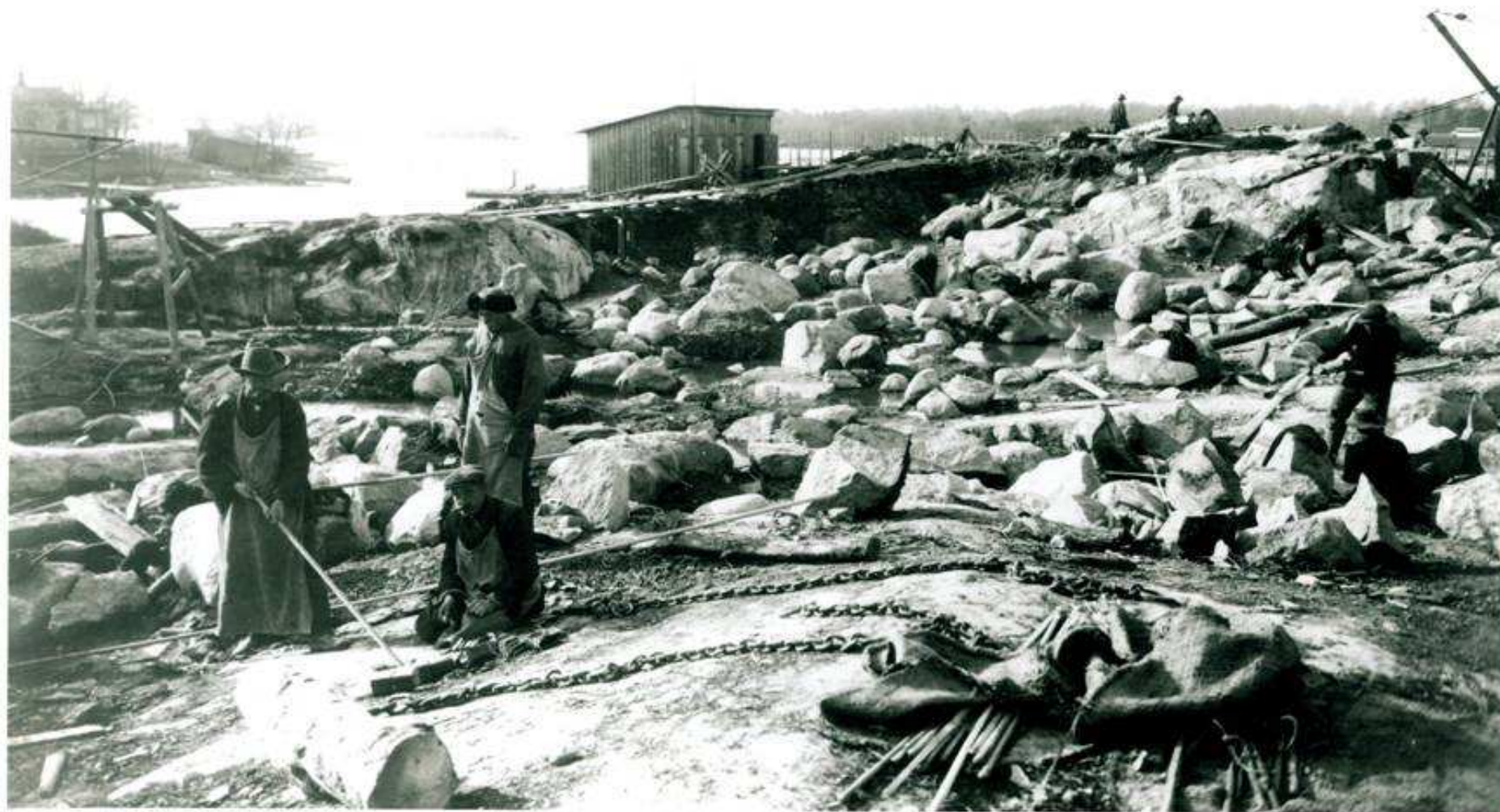
SATAMANRAKENNUSTÖITÄ JÄTKÄSAARESSA valok. Signe Brander 1913
