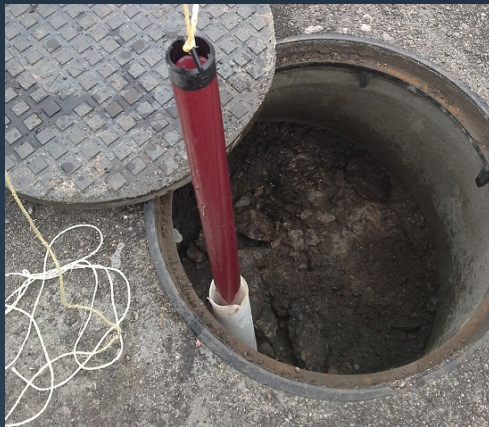
LR 2 ennen injektointia
