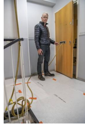
Sukituksessa paineilmaletkut vedetään kerrostaloasuntoihin postiluukun kautta, näyttää NF Sukitus Oy:n toimitusjohtaja Ismo Peltonen. Kuva: SSS/Minna Määttänen
